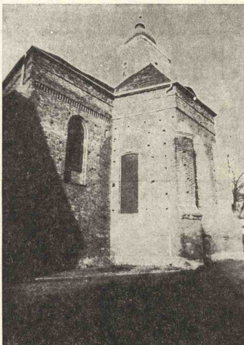
Średniowieczne mury kościoła św. Jadwigi w Zielonej Górze z widocznymi otworami do mocowania belek pod pomosty rusztowania (jednosłupowego).
