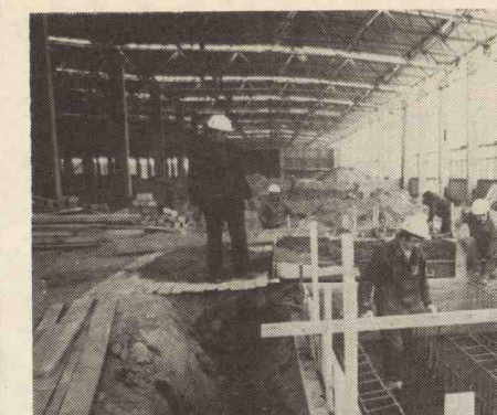
Zbrojenie fundamentów pod urządzenia wentylacyjne w hali agregatów igłowych.
