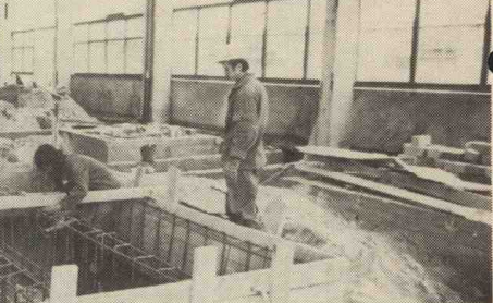
Zbrojenie fundamentów pod urządzenia wentylacyjne w hali agregatów igłowych.
