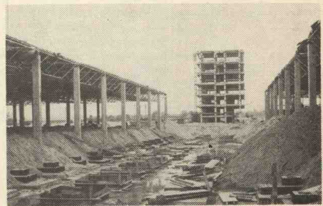
Fragment wykopu pod budynek socjalno-pomocniczy. W głębi betonowy szkielet przyszłego biurowca.
