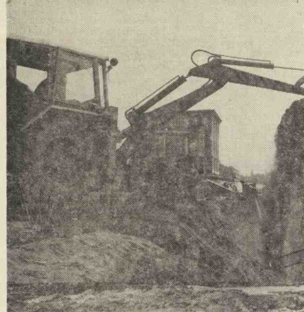
1972 r.: — ogólnopolski czyn partyjny: zdjęcie z wykonywania prac porządkowych na nabrzeżu Warty w Gorzowie Wlkp. „Do roboty grodzieńscy, okopywać rowy!” — nawiązywała już Maria Konopnicka! Foto. JAN SZAREJKO
