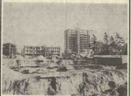
Fragment budowy Osiedla Braniborskiego.
