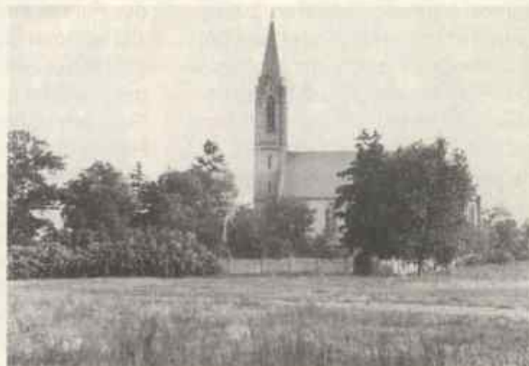
Die 1865 erbaute Kirche von Genninsch Warthebruch
