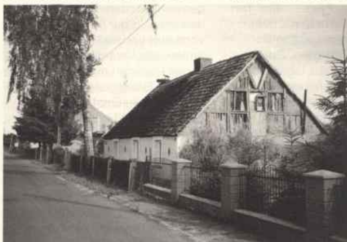
Ciecierzycze 2003. Das Haus von Rudolph Manthey auf der westlichen Südseite des Dorfes. Das Fachwerk traufenseitig ist verschwunden, und vorgemauert. Die Giebelseite wurde vom Wetter ausgespült. Freigelegt ist z.T. die Konstruktionsweise mit den in das Fachwerk eingestellten gespaltenen Holzstäben, die mit Stroh umwickelt und mit Lehm beworfen wurden
