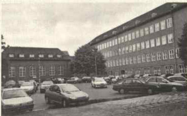
Das Äußere des Gebäudes ist unverändert
