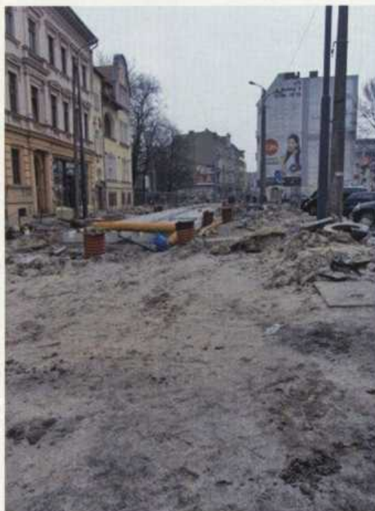
Gorzów/Landsberg baut in der ganzen Stadt
