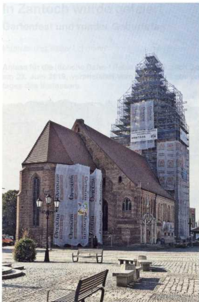
Die Marienkirche mit Baugerüst.
