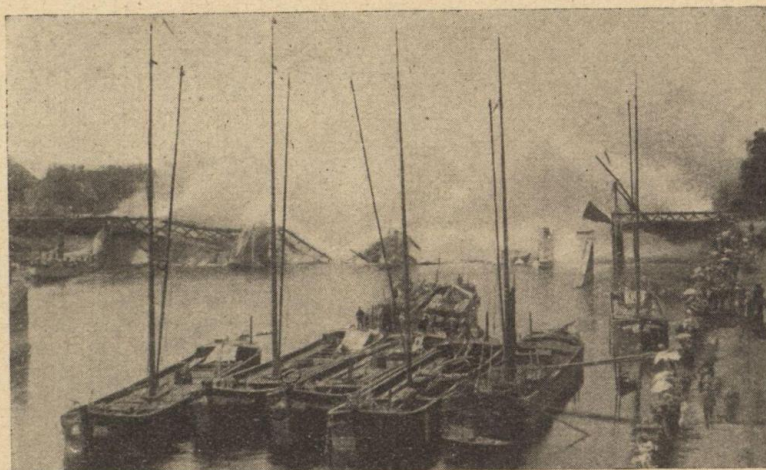
Der Brand der Warthebrücke am 1. Juli 1905
