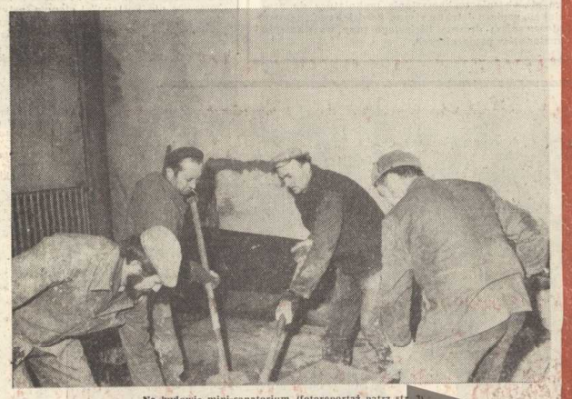
Na budowie mini-sanatorium (fotoreportaż patrz str. 3)
