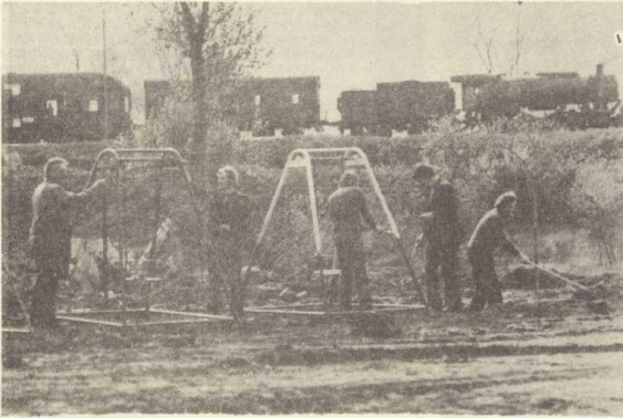
Energetycy pracują przy urządzeniu ogródka Jordanowskiego
