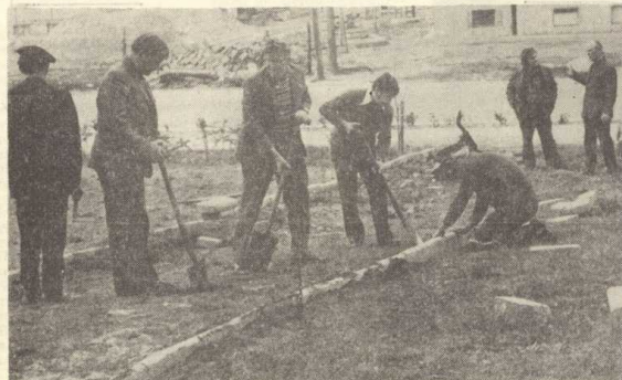
Członkowie organizacji miejskiej na placu robót przy zbiegu ulic Waśkiewicza i Sikorskiego
