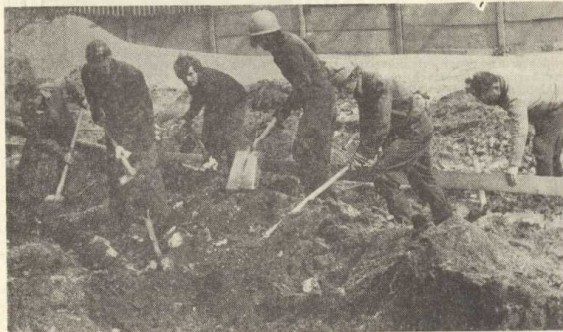
OOP - Oddziału Przygotowania Drewna buduje drogę
