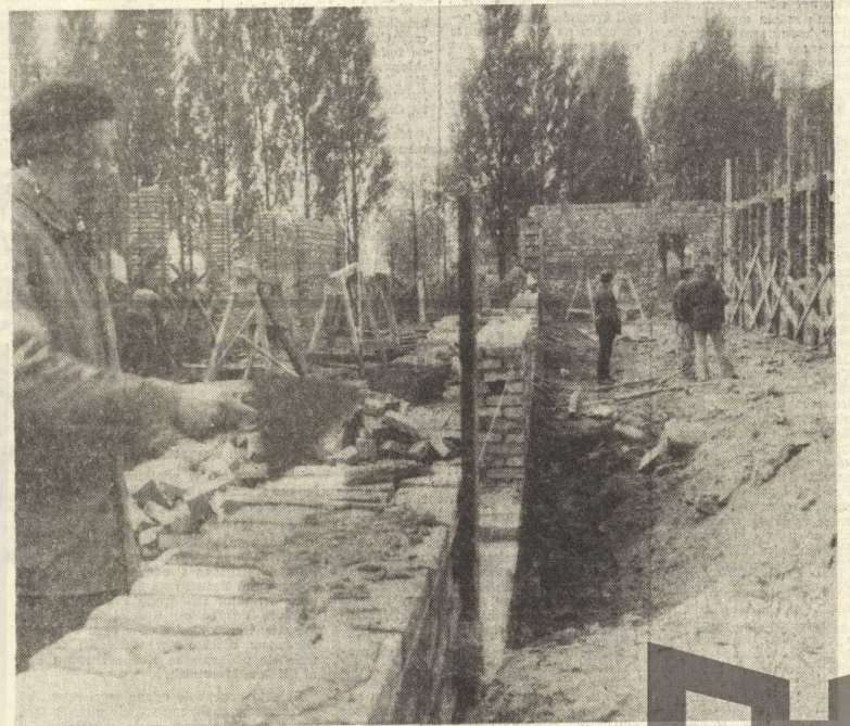
Zaświeconą tempa prac przy budowie szkolnego żłobka. Ogólny widok prac budowlanych.
