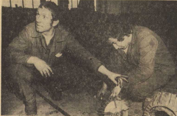
Brigadysta J. Briese i K. Jarnut przy montażu silnika elektrycznego.
