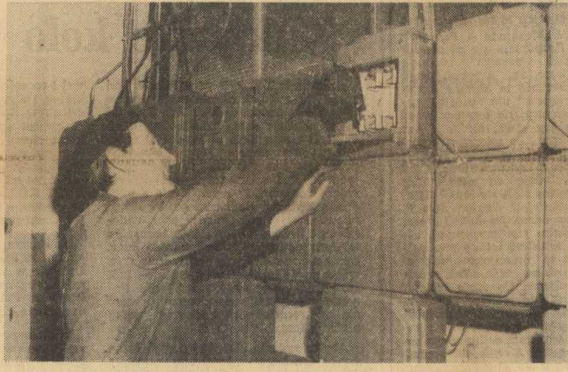
Starszy elektromonter dyżurny Celulozowni K. Wojtasek przy wymianie bezpieczników.
