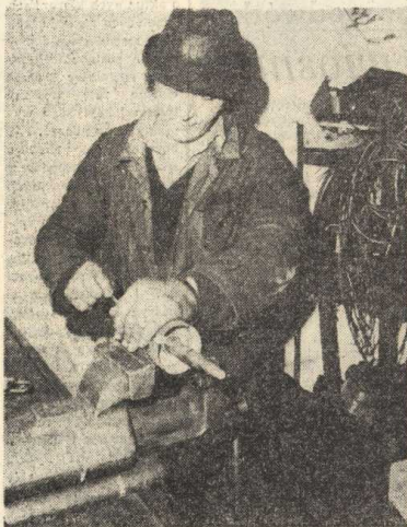
H. Korona — elektryk samochodowy. — regeneracja uciążnika rozrusznika.
