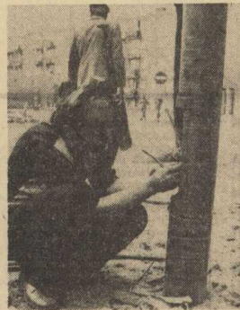
Przy instalacji elektrycznej pracownik Zakładu Energetycznego.
