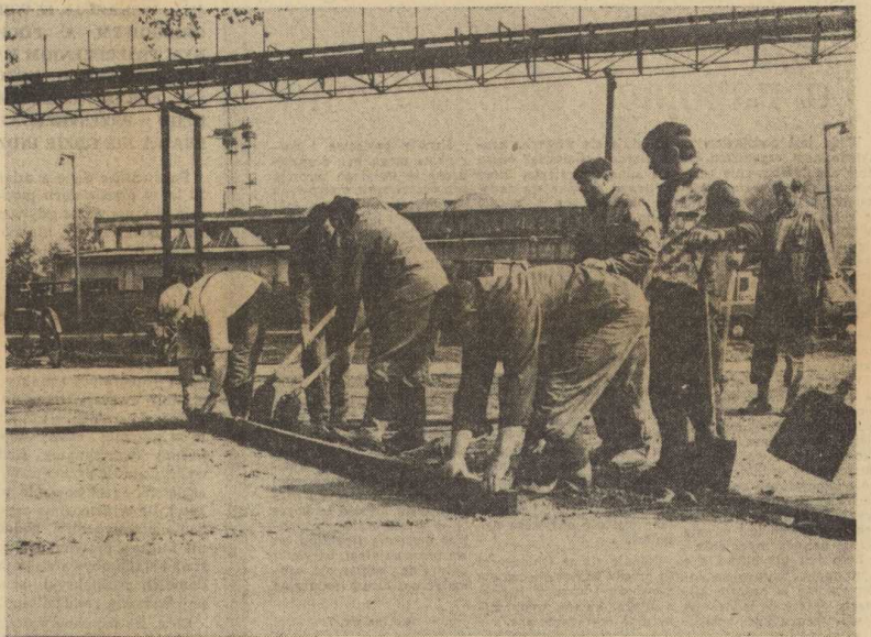
Utwardzanie terenu przy centralnej betoniarni — pracują pracownicy Wydziału Wykonawstwa Inwestycji.
