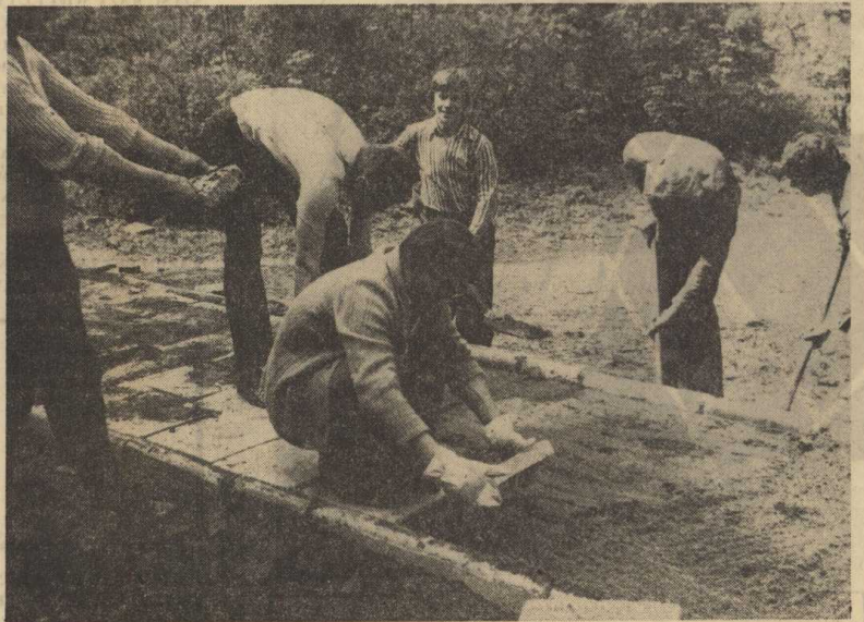
Przy układaniu płyt chodnikowych pracownicy ZREMB-u Kostrzyn.
