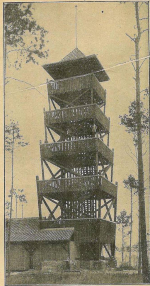
Abb. 16. Turm der Försterei Glumbeksee in der Oberförsterei Maffin. Die Eckpfosten, von Stockwerk zu Stockwerk nach innen versetzt, sind etwas nach außen geneigt
