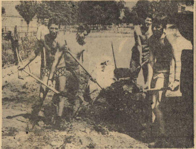
Będzie nowy chodnik na osiedlu domków
