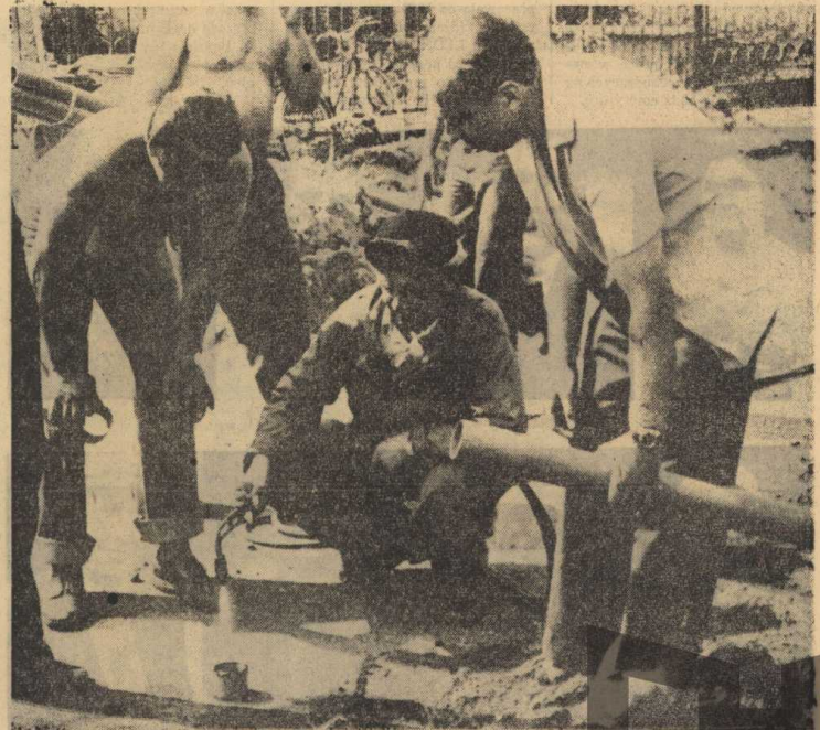
Zabłaganie rur do instalacji telefonicznej
