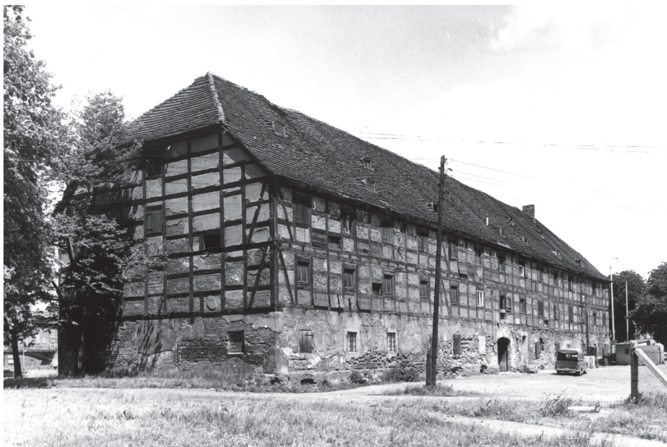
Spichlerz z II poł. XVIII wieku w Gorzowie Wlkp. przy ul. Fabrycznej przed remontem
