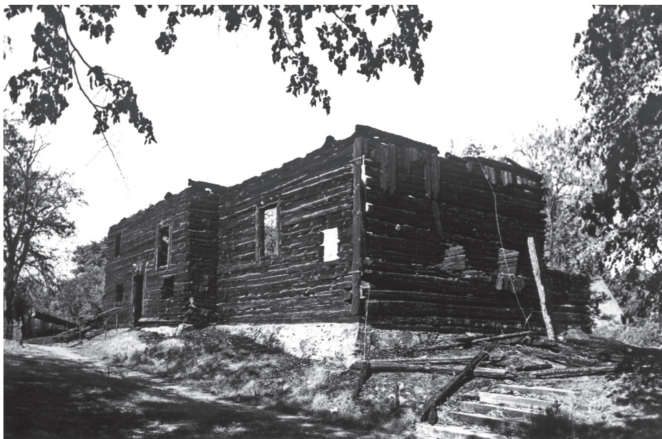
Kościół filialny pod wezwaniem św. Marcina w Bukowcu, pow. Międzyrzecz po pożarze w czerwcu 1978 r.
