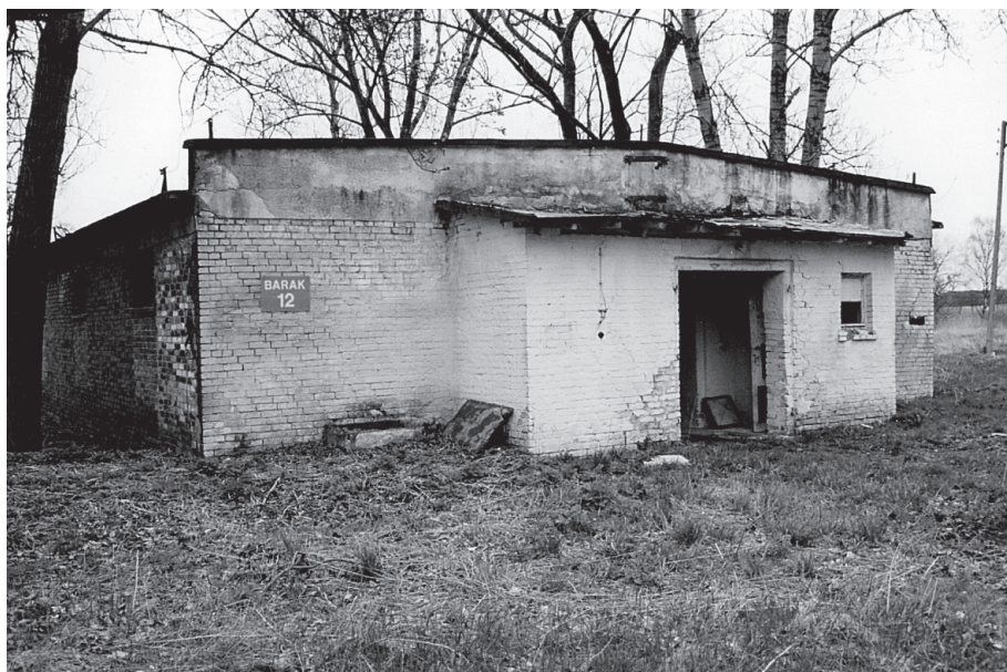
Fot. 6 Barak mieszkalny jeńców nr 12
