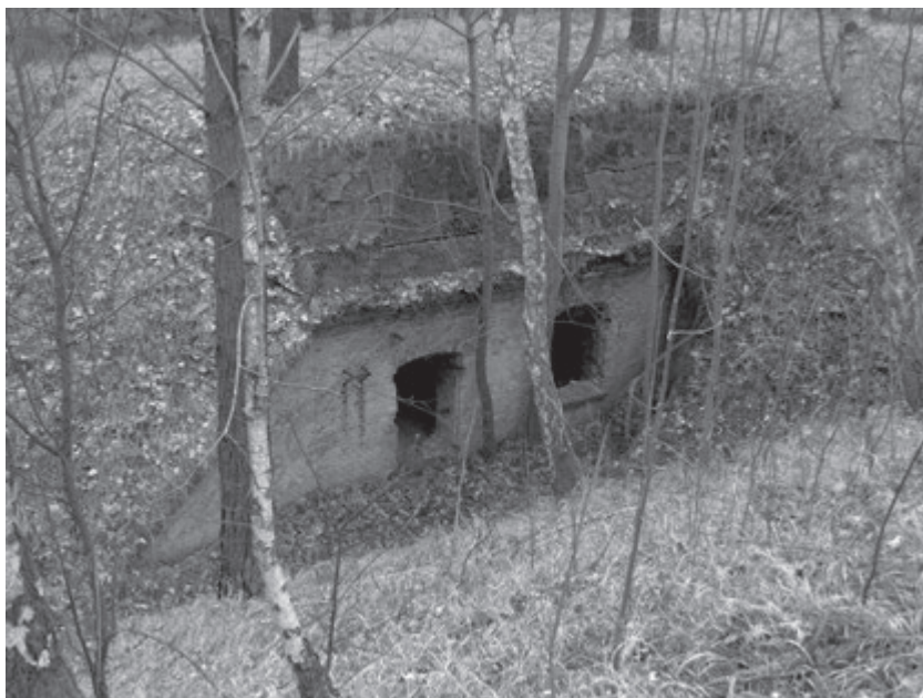
Foto 22: Schron pogotowia na wale piechoty
