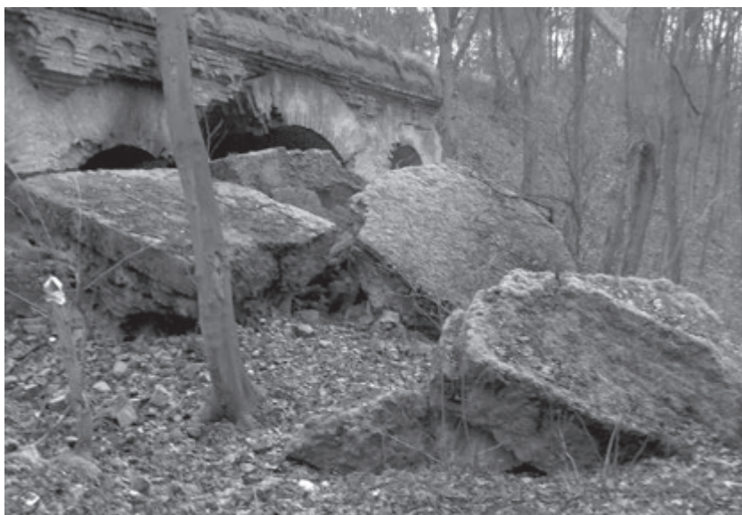
Foto 11: Destrukt kaponiery szyjowej
