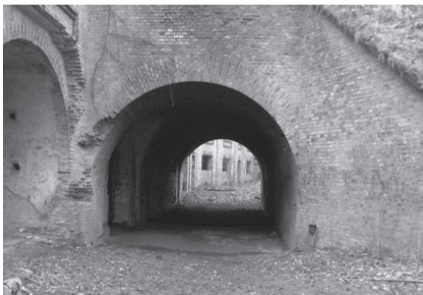
Foto 13: Przelotnia z poterny centralnej na dziedzińce koszar
