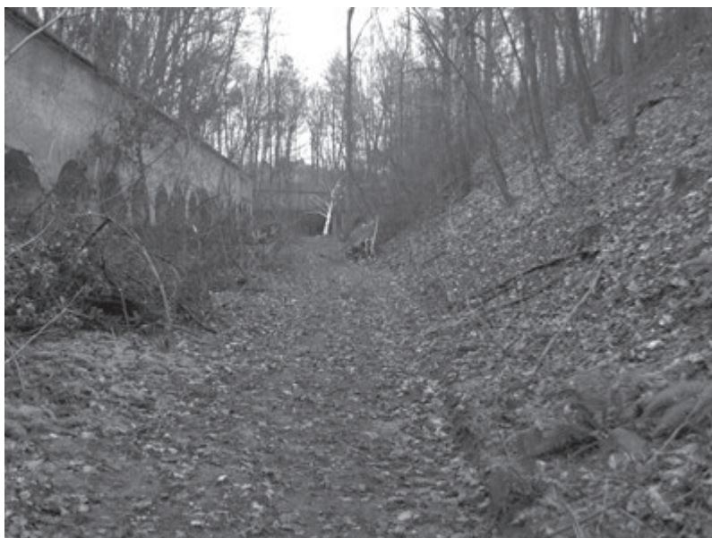
Foto 7: Widok przestrzeni fosy suchej; z lewej - mur przeciwstoku, z prawej - stok bojowy wału Foto 7: Ansicht des Trockengrabens; links: die Gegenböschungsmauer, rechts: die Kampf- böschung des Walls
