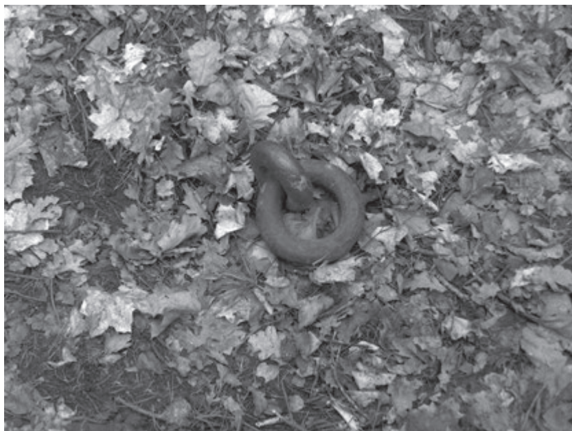
Foto 17: Masywne ogniwo zakotwione w nasypie rampy. Mocowano tu wielokrążek do wciągania armat na lawę działową
