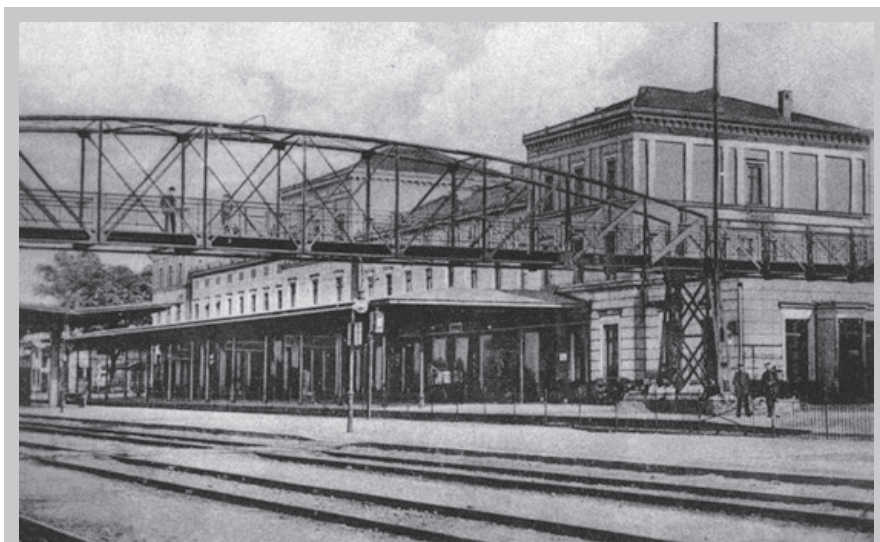
Krzyż – dworzec, budynek główny przed 1945 r.
