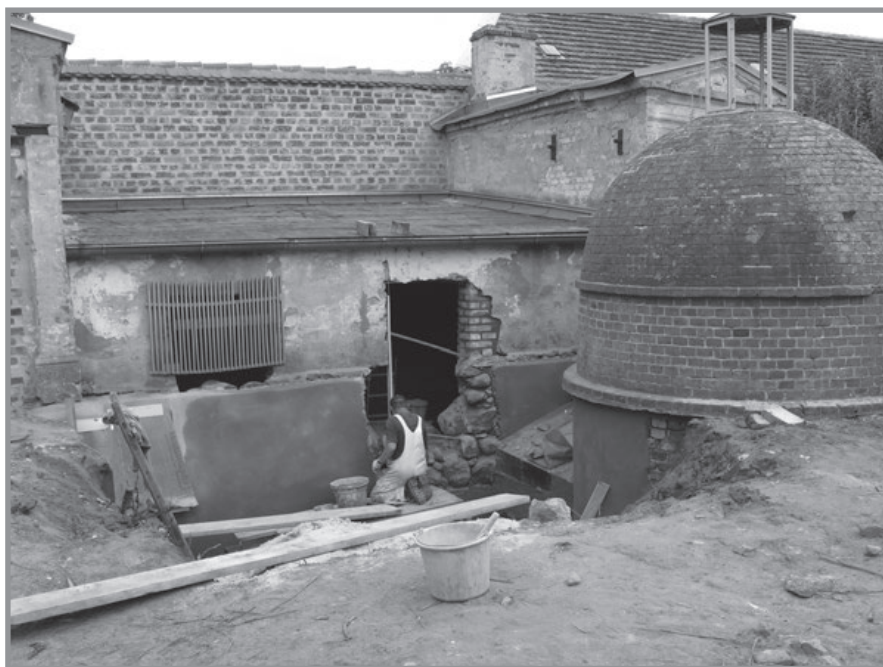
Mykwa w Schwedt, prace konserwatorskie Die Mikwe in Schwedt, Sanierungsarbeiten
