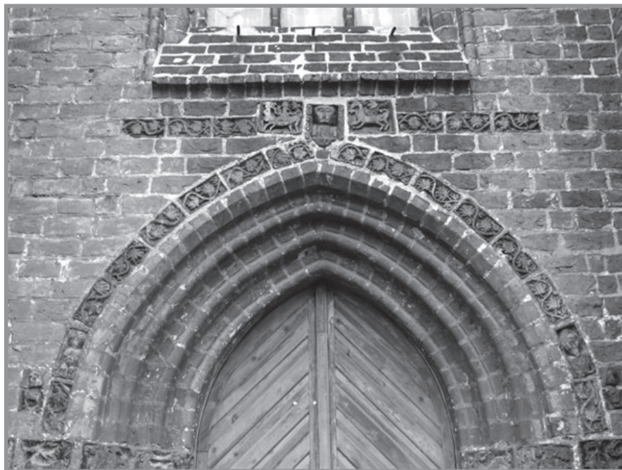
Fot. 1: Dobiegniew, portal południowy, widok ogólny
