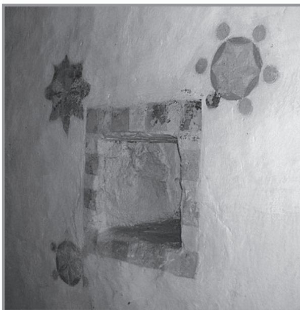
Fot. 47: Moryń, kościół parafialny, nisza I w ścianie prezbiterium
