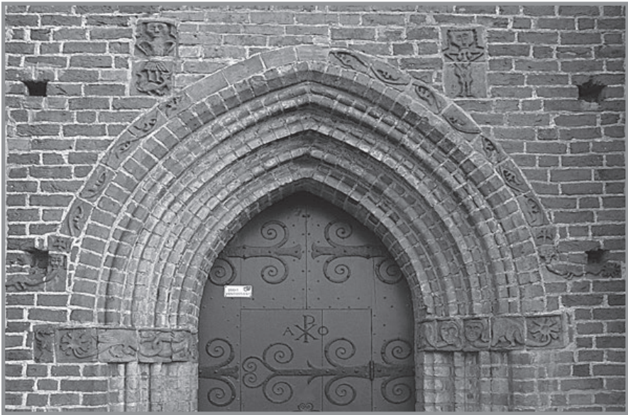
Fot. 37: Drawsko Pomorskie, portal północny, widok ogólny Fot. 37: Drawsko Pomorskie (Dramburg), Nordportal, Gesamtansicht
