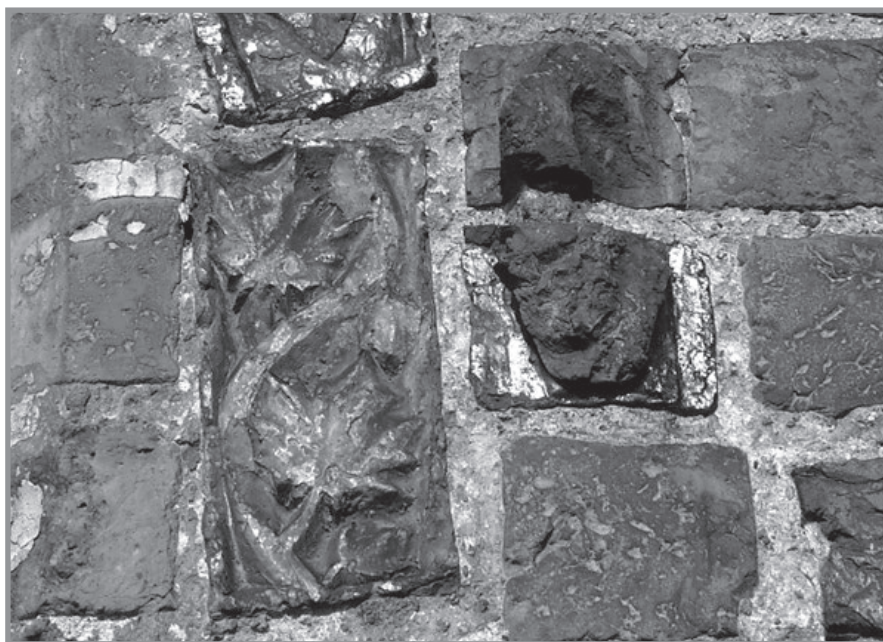
Fot. 14: Dobiegniew, portal południowy, chleb II (?) Fot. 14: Dobiegniew (Woldenberg), Südportal, Brot II (?)
