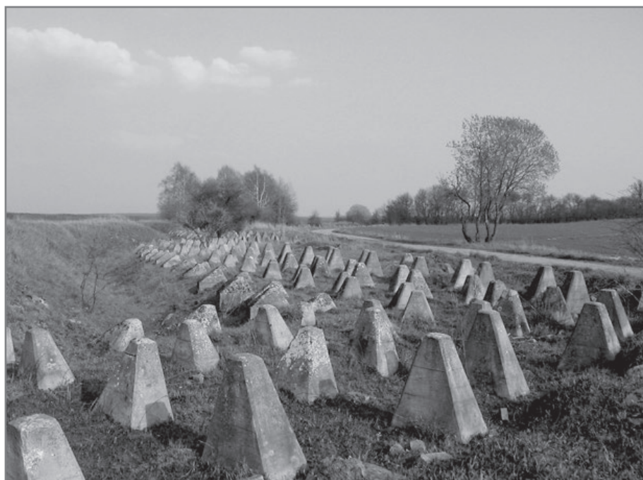
Zapora ppanc. zęby smoka w rejonie Kęszycy. Przeciwnskarpa i rów poprzedzający betonowe słupy wyprofilowano w 1944 r. (stan na 2005 r.). Fot. G. Urbanek
