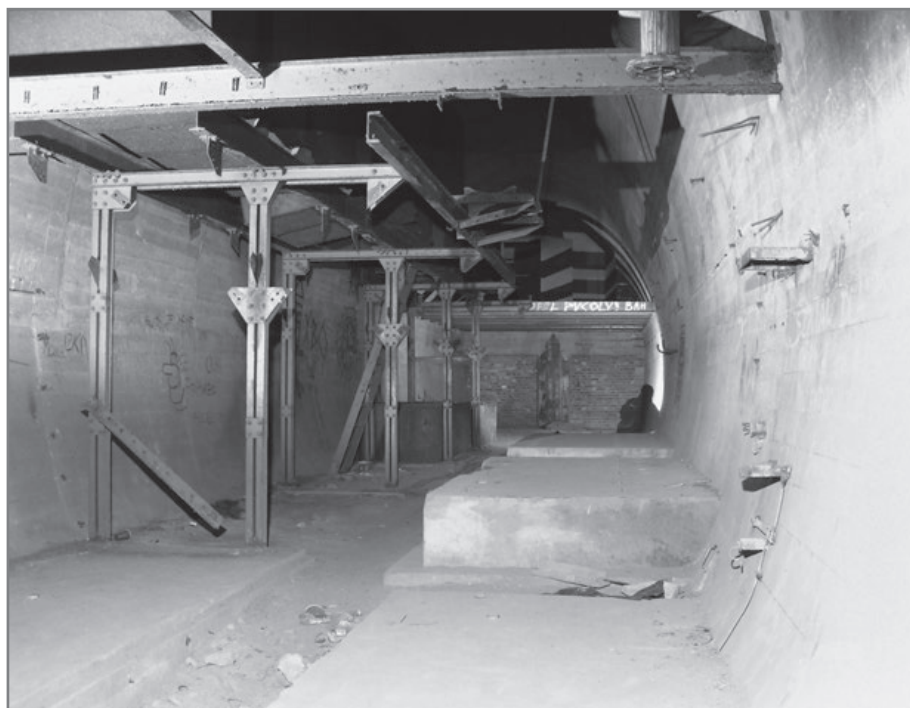
Maszynownia Pz.W. 715 z zachowanymi zbiornikami na ropę (stan na 2005 r.). Obiekt podczas obrony MRU był jednym z odcinkowych punktów dowodzenia. Fot. Jan Wasilkiewicz
