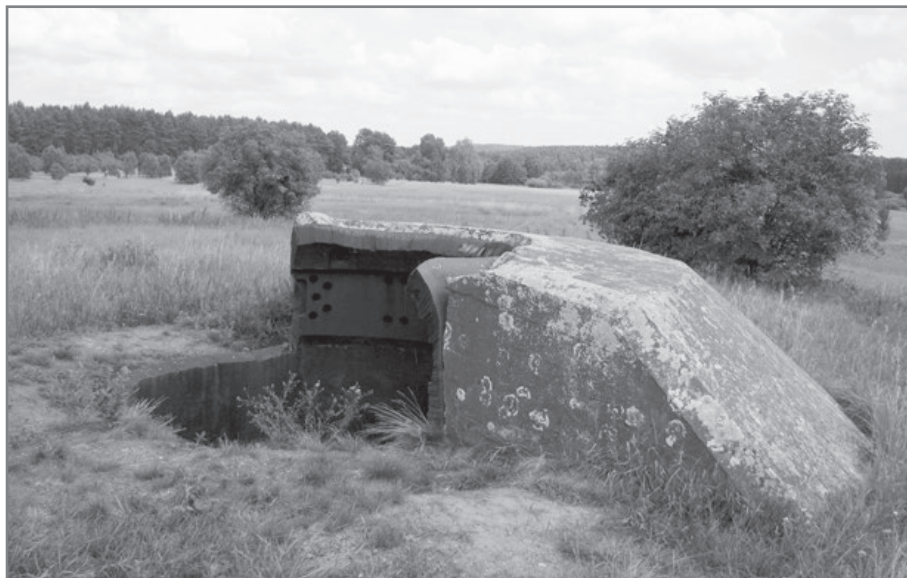
Betonowa osłona kopuły pancerniej w Pz. W. 677 z Grupy Warownej „Litzmann” w Mostkach (stan na 2007 r.). Fot. G. Urbanek
