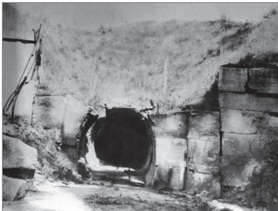
Wjazd do podziemi A 64, wysadzony krótko przed nadejściem Rosjan. Fotografia wykonana w II poł. lat 40. XX wieku. Zbiory Muzeum Fortyfikacji i Nietoperzy w Pniewie
