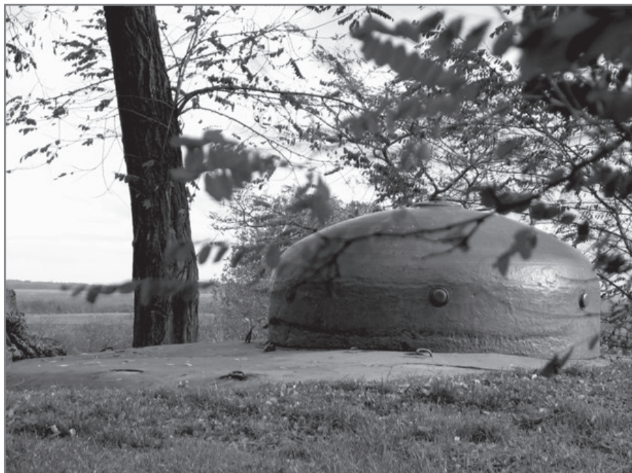
Zablokowane stalowymi bolcami otwory boczne w kopule obserwatora piechoty Pz.W. 716 (stan na 2012 r.). Fot. G. Urbanek
