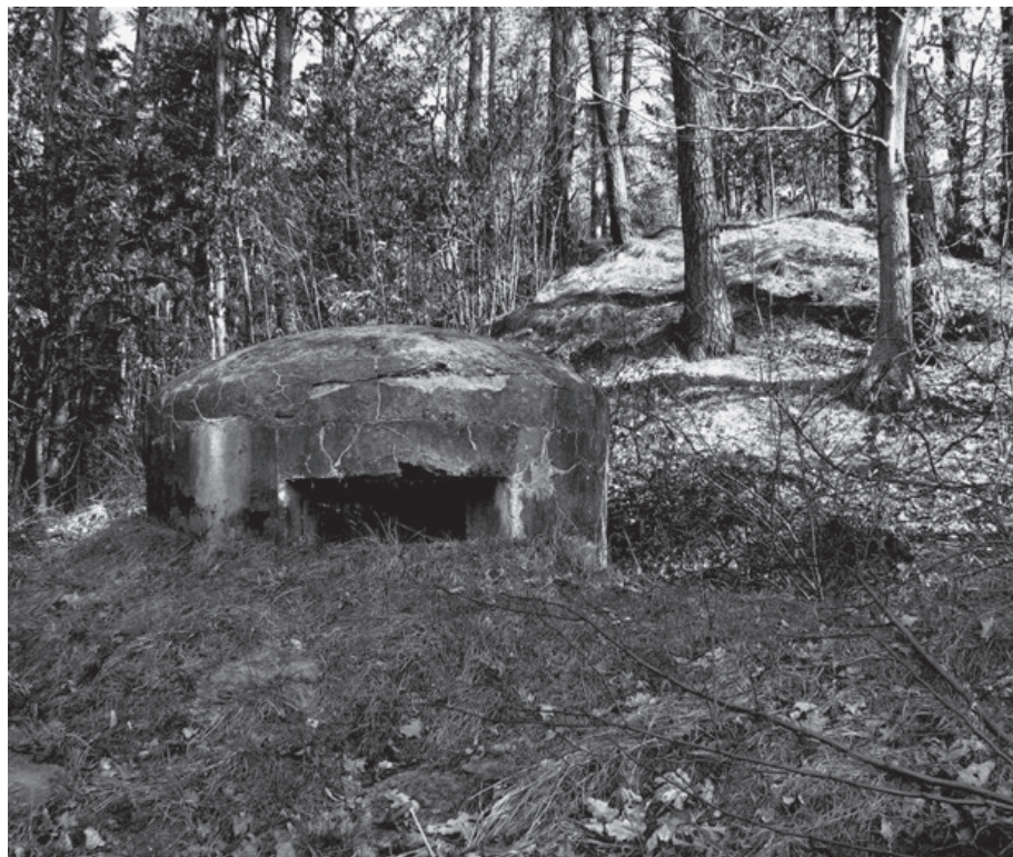
Ryc. 12. Stanowisko Kochbunker z 1944 r. przy drodze wojewódzkiej 136. Fot. G. Urbanek, 2007
