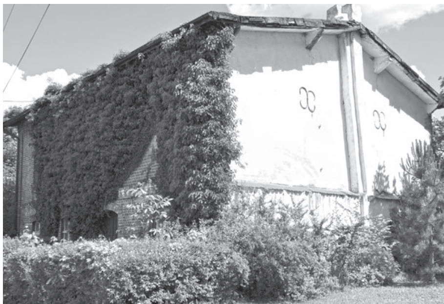
Budynek po młynie w Żerdnie, fot. Z. Mieczkowski
