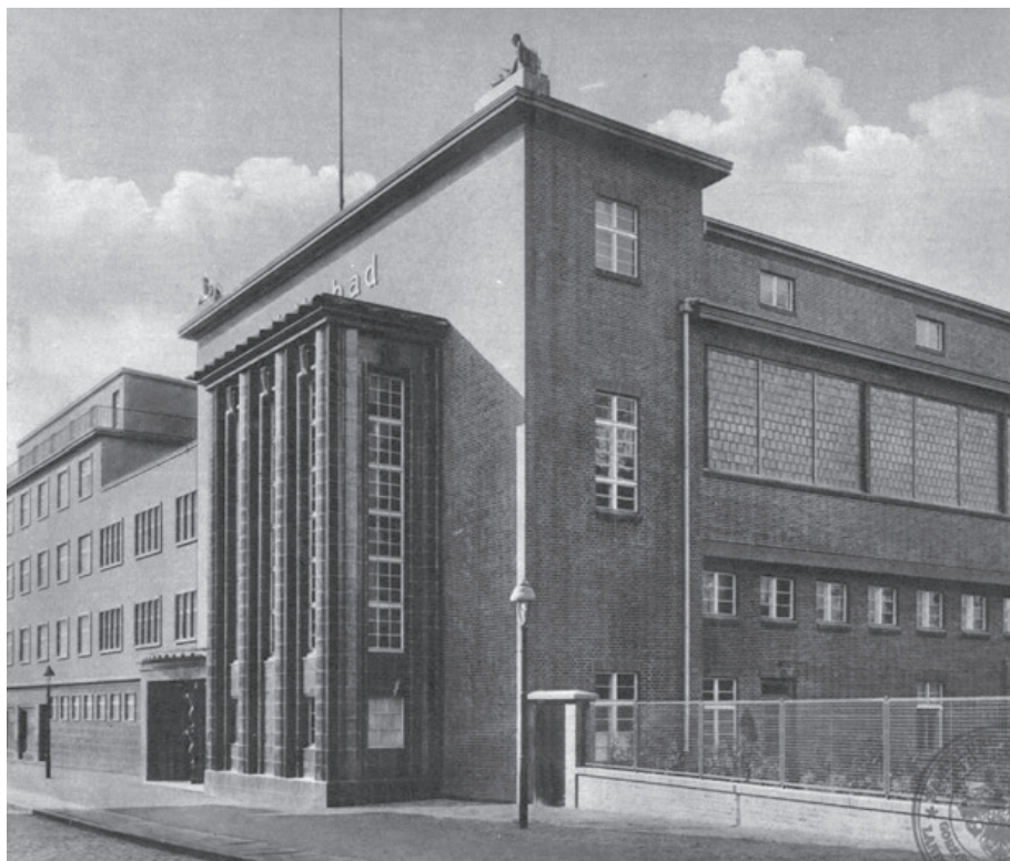
Budynek Łaźni Miejskiej (1928-30) ze stworzonymi w kolonii artystycznej Gildenhall koło Neuruppina elementami ceramicznymi i rzeźbiarskimi, w większości zachowanymi do dziś, fot. Kurt Aurig, lata 30. XX w.
