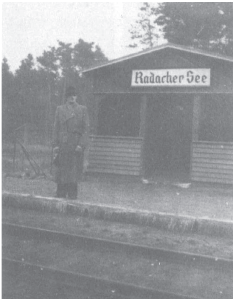
Przystanek kolejowy Radacher See, źródło: M. Maksymczak-Żyła, R. Ochwat, J. Piskorska, op. cit., s. 201
