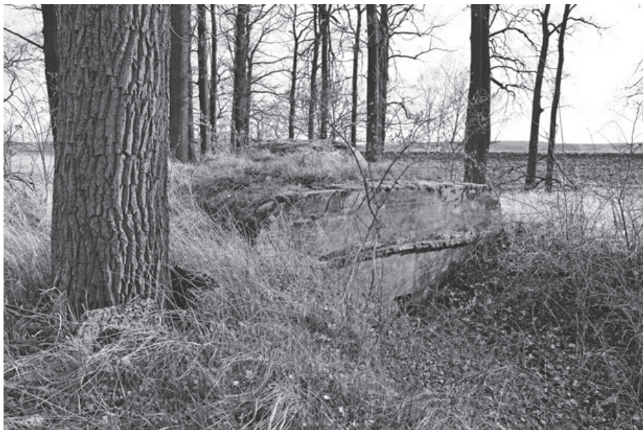
Ryc. 8. Schron bojowy B. 1 odcinka Będów. Widoczna płyta stalowa o grubości 8 cm oraz otwór strzelnicy ckm, fot. Dariusz Pstuś 2017
