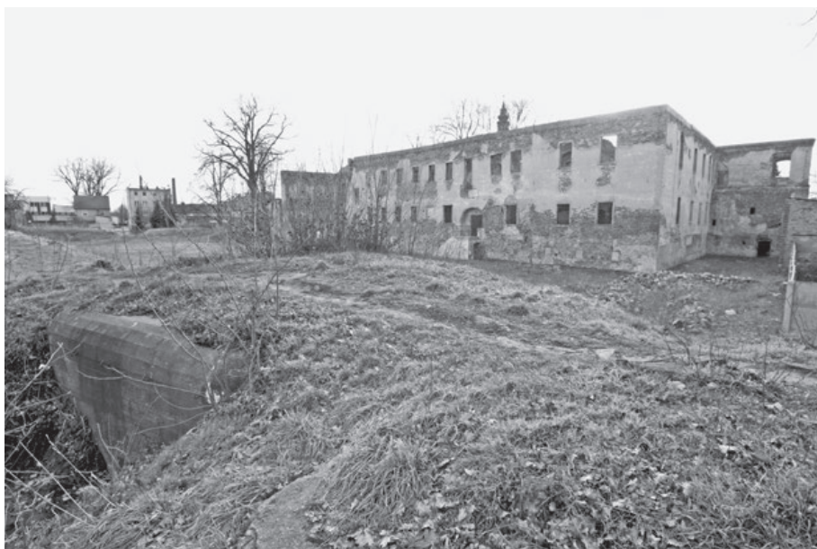
Ryc. 3. Schron bojowy (MG-Schartenstand C. 9) w kurtynie wału szwedzkich fortyfikacji przylegających do terenu zamku w Krośnie Odrzańskim, fot. Wojciech Opyrchal 2009
