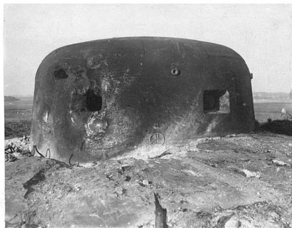
ПРАВЫЙ БРОНЕВОЙ КОЛПАК Прямое попадание снаряда в амбразуру. Расход = 21 снаряд.
