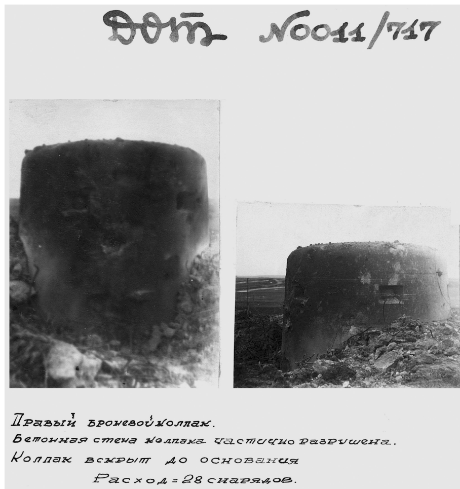
Рис. 14. Schron Pz.W. 717 (0011 / 717). Prawa kopuła sześciostrzelnicowa dla 1 km
