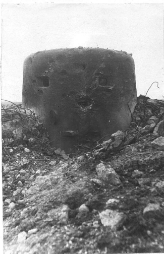
Правый броневой колпак. Бетонная стена колпака частично разрушена. Колпак вскрыт. Расход = 28 см.
