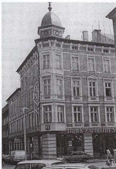
* Kamienice przy ulicy Obotryckiej, obecnie Bank Zachodni i Dom Rzemiosł.
