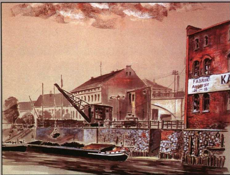
Nadbrzeże Warty, fragment magazynu solnego. W głębi dom nr 13/14 przy ul. Nadbrzeżnej. (1943)
