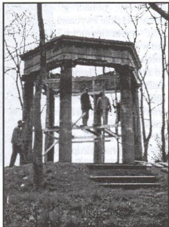
Początek remontu pawilonu
