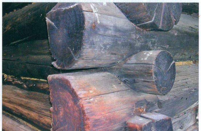
Bild 3: Eck-Verzahnung bei Rundhölzern. (Bild: Wikipedia)
