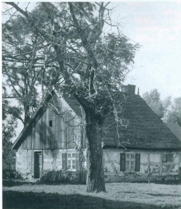
Typische Bauweise in Zettritz: Fachwerk mit Stroh umwickelt und mit Lehm beworfen. (Bild: Aurig)
