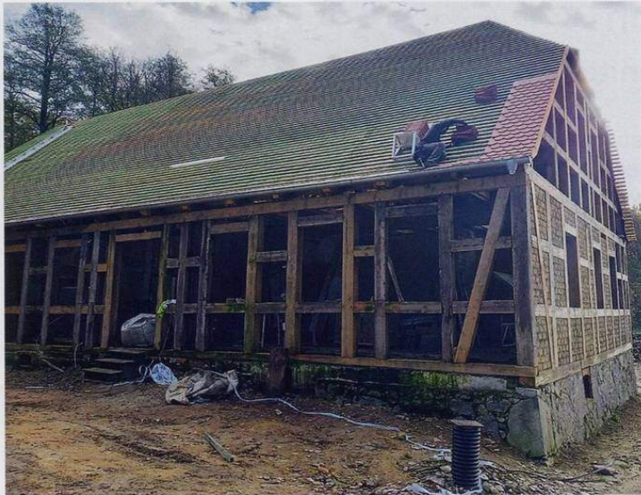
Das Dach wird mit Biberschwanzziegeln eingedeckt.
