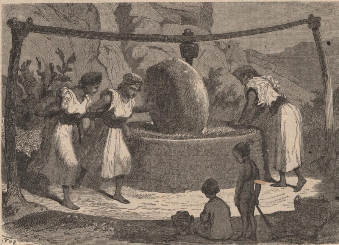
Eine babylonische Mühle zum Quetschen der Oliven. (S. 147.)
