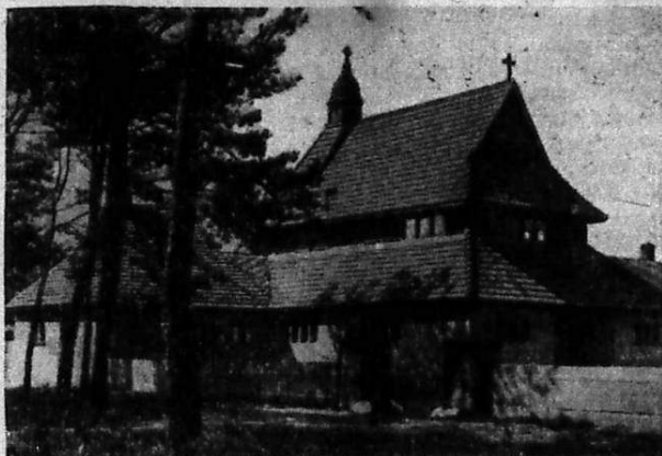
Kaplica Zakładowa w Laskach
