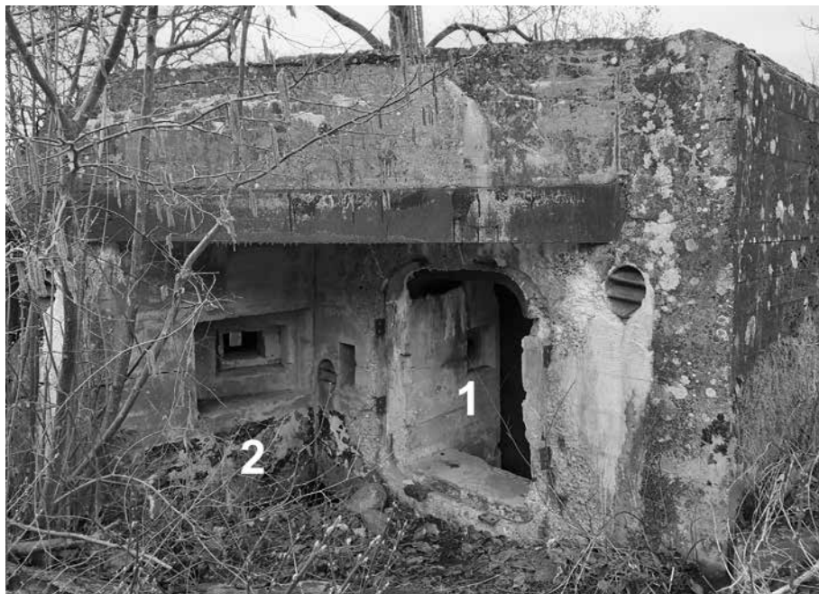
Ryc. 7. Ściana wejściowa schronu bojowego nr Zw. 7. Od prawej: 1. otwór wejściowy do schronu onegdaj zabezpieczony drzwiami stalowymi typu 14P7; 2. strzelnica karabinowa z wyprofilowaniem przeciwykoszetowym, fot. K. Motyl, marzec 2024
