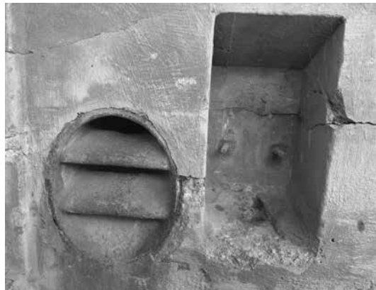
Ryc. 8. Ściana gazoszczelna schronu (fragment). Od lewej: stalowa osłona (czerpnia owoidalna typu 12ML1) otworu wentylacyjnego (wywiew zużytego powietrza ze śluzu). Obok znajduje się podłużna nisza, w której zainstalowane było przyłącze kabli telefonicznych, fot. K. Motyl 2024
