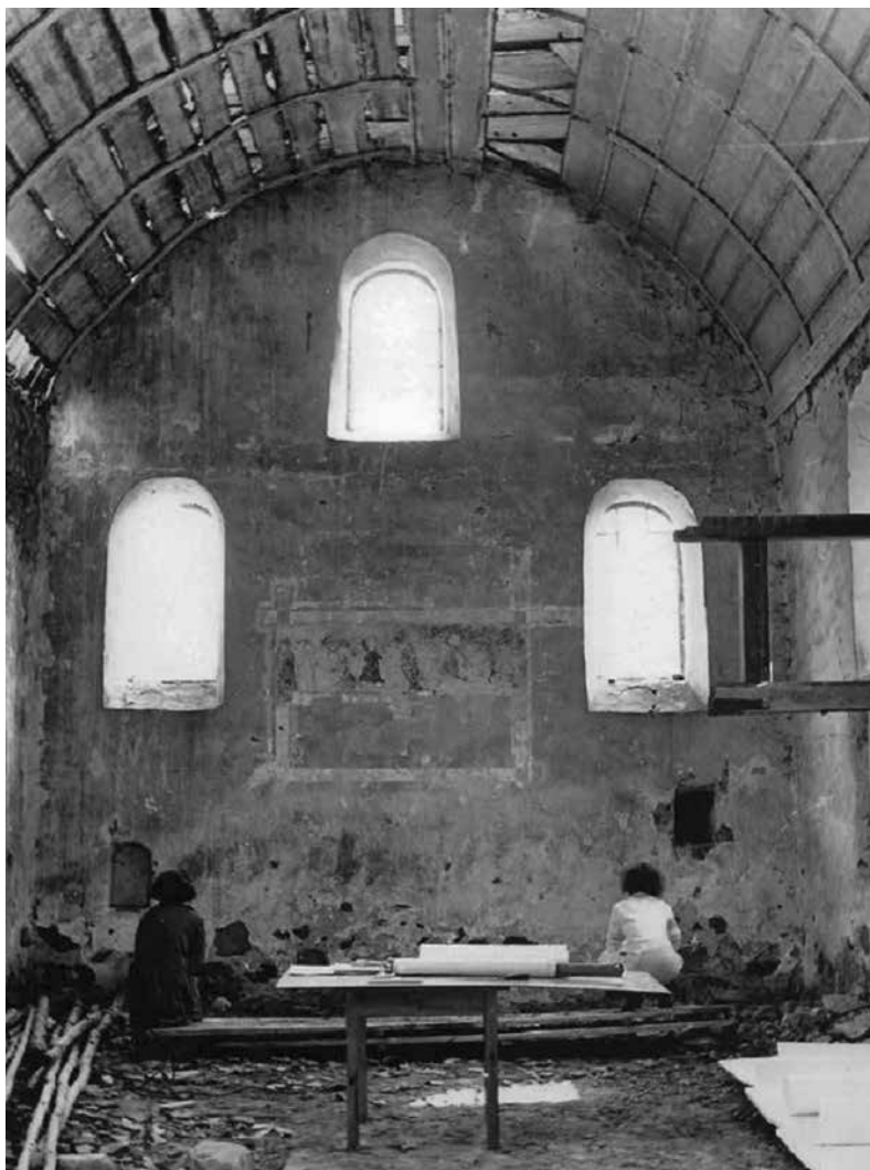
Ryc. 6. Pracownicy ASP w Krakowie zdejmujący malowidła ścienne w kościele w Starkowie (26.04.1966 r.), fot. Z. Brandke
