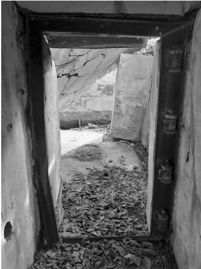
Ryc. 9. Śluza gazoszczelna. Przejście do pomieszczenia bojowego było zabezpieczone dwudzielnymi, gazoszczelnymi drzwiami stalowymi typu 17P7. Jedynek reliktem po drzwiach jest ościeżnica, w której nadal tkwią zawiasy. Po lewej stronie, w ścianie, nad posadzką zauważalny jest okrągły otwór wentylacyjny będący wywiewem zużytego powietrza z pomieszczenia bojowego do śluzy, fot. K. Motyl 2024
