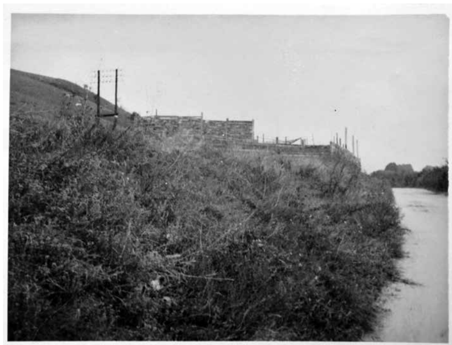
Ryc. 5. Zdjęcie z 1938 r. wykonane przez agenta polskiego wywiadu, prezentujące wznoszenie konstrukcji maskującej schronu bojowego Zw. 7, źródło: D. Pstuś, op. cit. , s. 74
