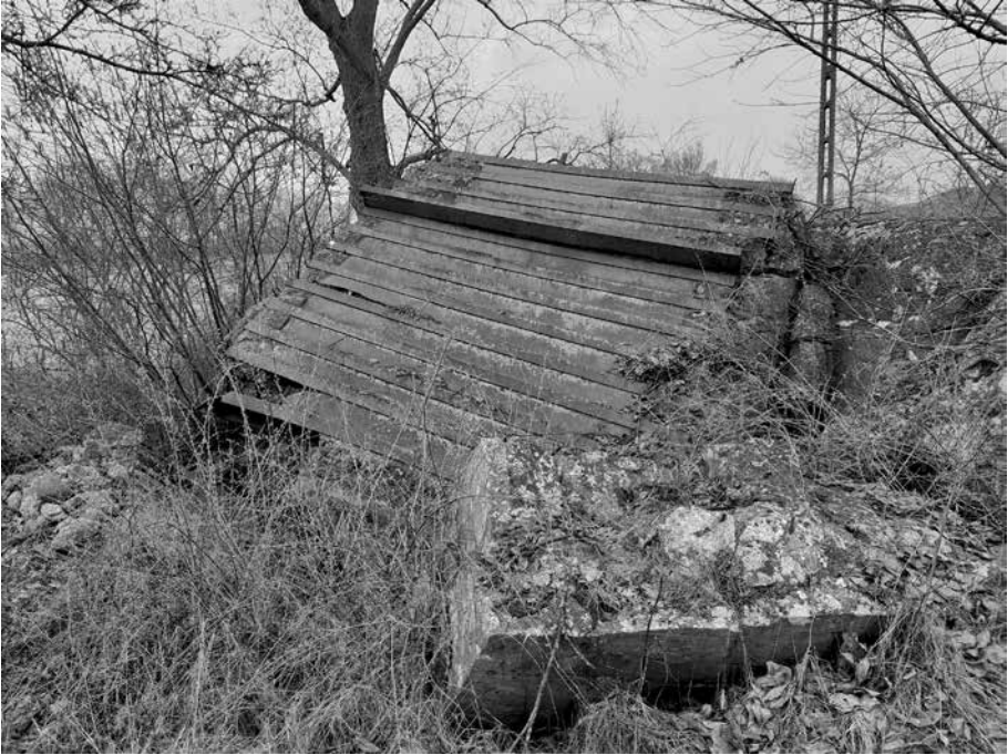
Ryc. 16. Widok ogólny na pomieszczenie bojowe schronu, w którym tkwi odsadzony stropodach. Zauważalna jest konstrukcja sklepienia, na którą składają się kształtowniki stropowe wraz arkuszami blachy stalowej pełniące funkcję przeciwodpryskową. Na planie pierwszym widoczny jest fragment odsadzonej i przemieszczonej ściany zewnętrznej pomieszczenia bojowego, fot. K. Motyl 2024
