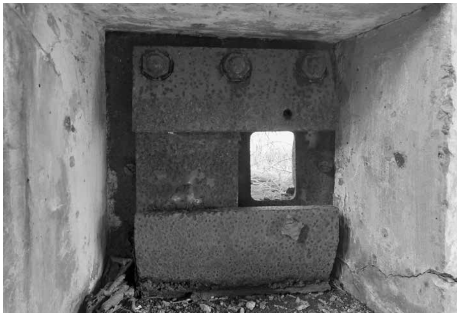
Ryc. 10. Płyta stalowa typu 48P8 osadzona w strzelnicy obrony wejścia. Panczerz posiada zachowane prowadnice wraz zasuwą. Zauważalne są nieliczne pozostałości białej farby olejnej, którym była pokryta powierzchnia do strony pomieszczenia bojowego, fot. K. Motyl 2024
