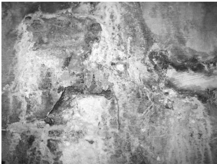
Ryc. 15. Resztki sygnatury „Zw. 7” odkryte w słuzie wejściowej po skuciu ze ściany zacieku wodno-wapiennego, fot. G. Urbanek 2005
