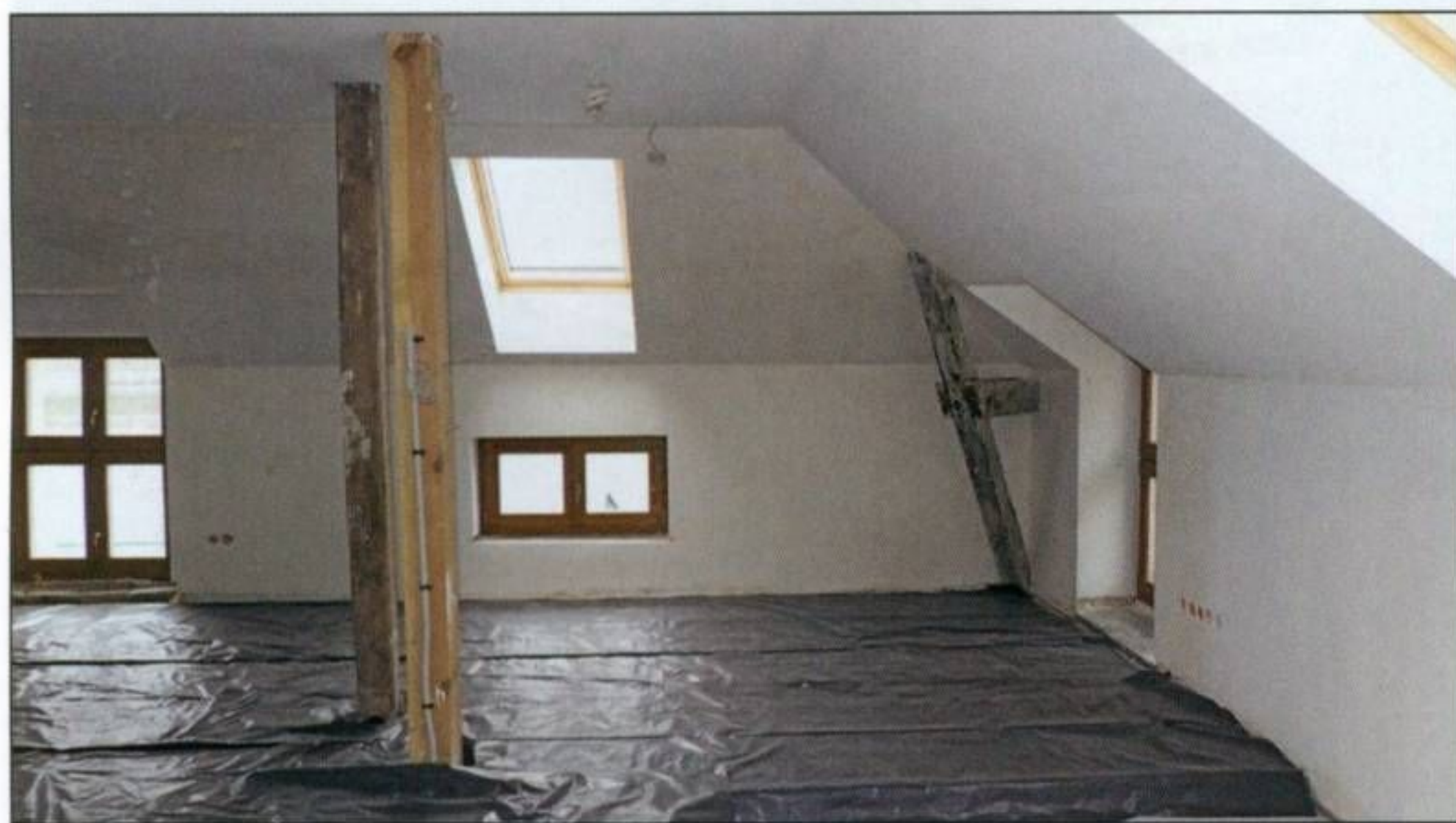
Im Dachgeschoss entstehen in moderner Bauweise Gästezimmer; die historische Holzkonstruktion wird gezeigt, soweit z. B. die Brandschutzbestimmungen dies erlauben.
