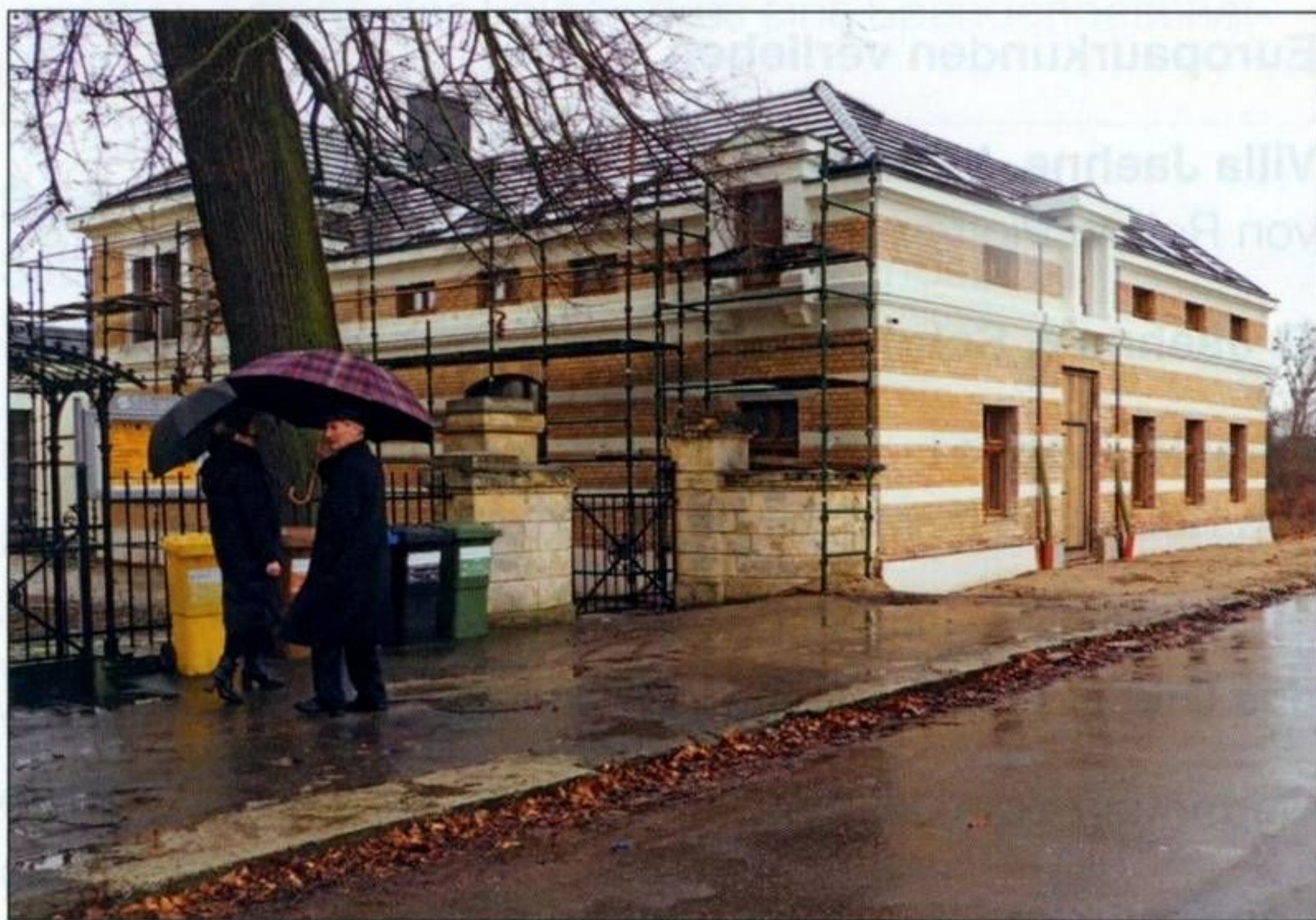
Die Nebengebäude, das ist die Remise mit den anschließenden Gebäudetrakten, einschließlich Maschinenhaus, sind außen völlig restauriert, hervorheben möchte ich die historisch passenden Fenster.
