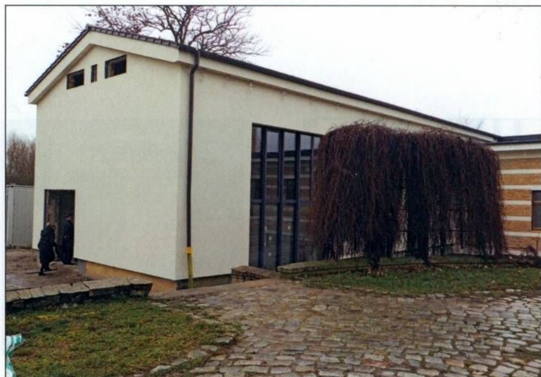
Blick vom Hof auf das ehemalige Maschinenhaus. Wo früher mit Dampfmaschine elektrischer Strom und Wärme zum Heizen erzeugt wurde, wird künftig ein großer Vortragsaal mit großen, modernen, bis zum Boden reichenden Fenstern für Schulungen und andere Veranstaltungen genutzt werden.
