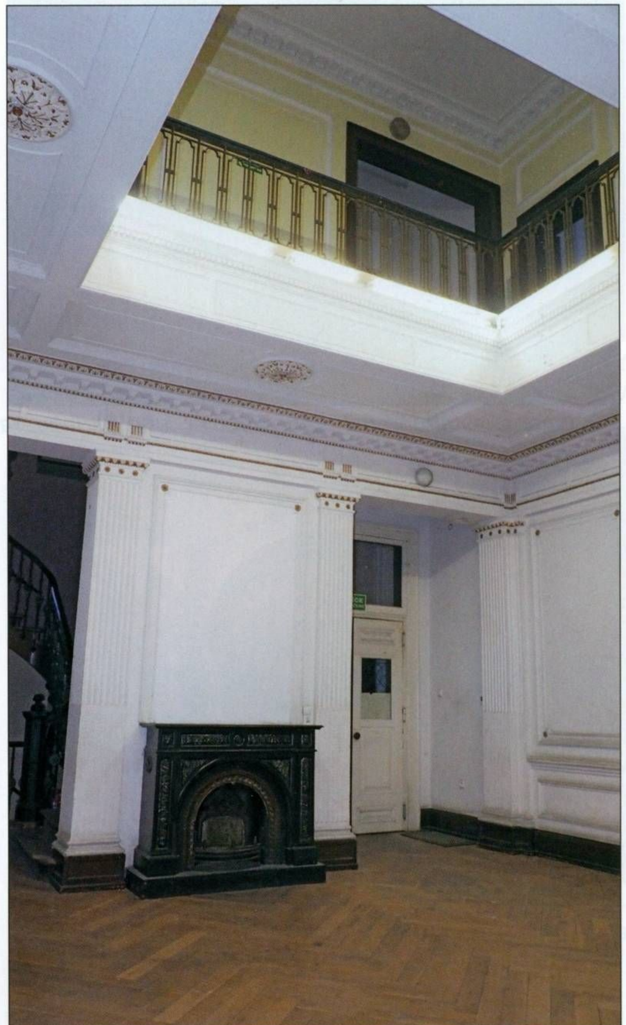
Der erste Eindruck im Vestibül in der Villa. Da das Gebäude zwar in vielfältiger Nutzung, doch stets angemessen gepflegt und zwischendurch auch renoviert worden ist, ist die Villa zu Beginn dieser Totalrestaurierung in einem vergleichsweise guten Zustand.
