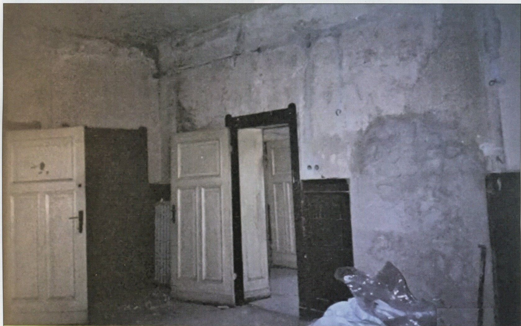
... und unten vor der Renovierung. Auch der zugemauerte Kamin ist wieder vorhanden.
