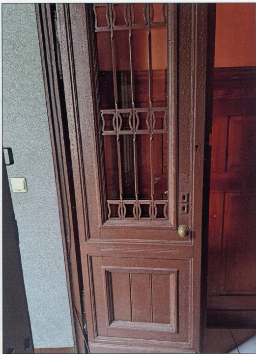
Der „Gehflügel“ der Eingangstüre.
