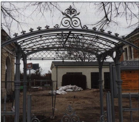
Die gesamte straßenseitige Zaunanlage einschließlich des Eingangsportals ist komplett wiederhergestellt und montiert, der Blick geht über den Hof auf das ehemalige Maschinenhaus.
