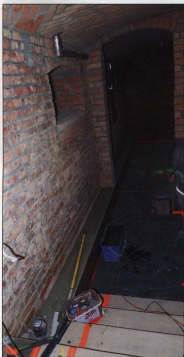
Ein Blick in den künftigen Weinkeller, die aktuellen Estricharbeiten bereiten den Fliesenbelag vor.
