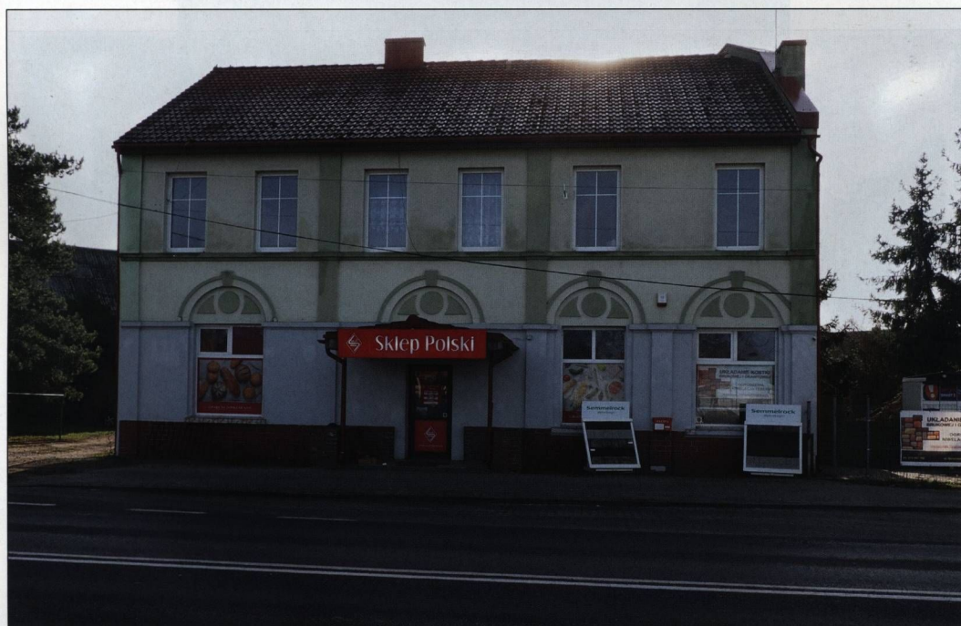
Eine Aufnahme desselben Gebäudes vom 29. Januar 2024, die Architektur des Hauses ist gut erhalten und aktuell farblich angenehm gestaltet. Im Erdgeschoss befindet sich ein Geschäft für Lebensmittel und Backwaren. (JU)
