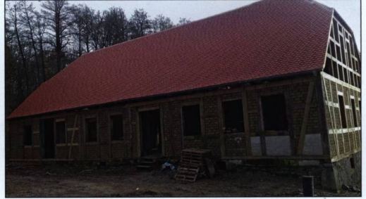
Die Ausfachung des Fachwerks ist komplett erneuert, der Dachstuhl ist wieder stabil und neu gedeckt. (Bild: Muz. Lub.)
