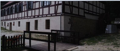
Blick auf das Mühlengebäude von der Hofseite, rechts ist das Mühlrad zu sehen.
