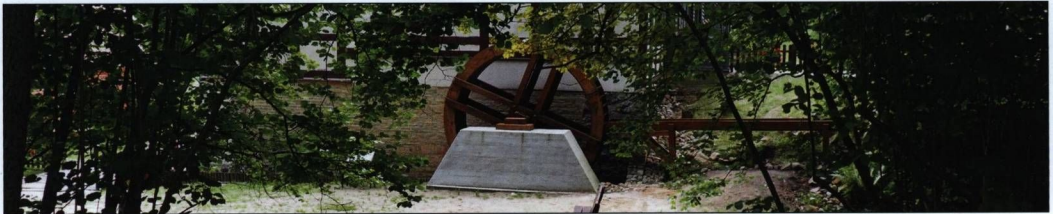
Obwohl bereits 1936 nicht mehr benutzt, wurde der Anschauung halber das hölzerne Mühlrad rekonstruiert. Bei einer ungefähren Fallhöhe des Wassers von 2 Metern ist es ein unterschlächtiges Mühlrad, das Wasser wird gleich in einem Kanal zum Bachlauf zurück geleitet.
