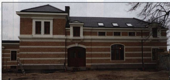
Die fertiggestellte Fassade der Remise von der Hofseite aus, hervorzuheben sind die historisierenden Fenster.
