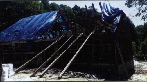
Das Gebäude wurde vollkommen entkernt, marodes Holz vom Dachstuhl ersetzt, die Ausfachung entfernt. (Bild: Muz. Lub.)
