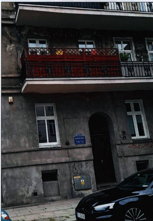
Das ehemalige Wohnhaus meiner Mutter in der damaligen Röstelstraße 11, die Hausnummer ist noch immer die 11.
