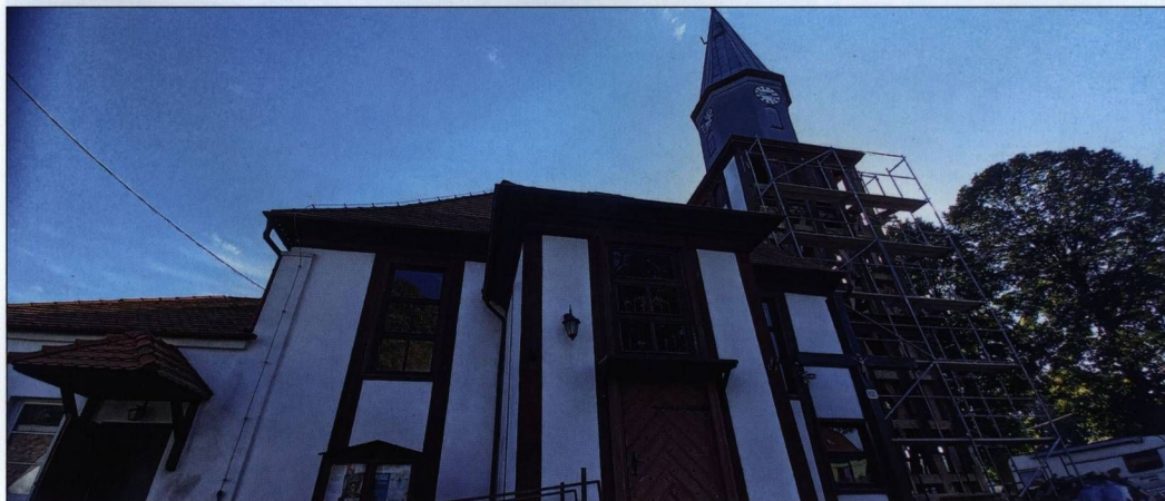
Im nächsten Jahr erhält die kleine Kirche eine Generalsanierung. Bilder: RP
