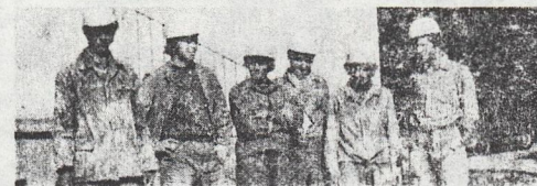
Kierownik budowy bazy magazynowej WSS chwali sobie również pracę brigady murarzy — tynkarzy Józefa Balcercza.
