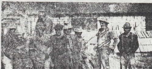
Brigada Alfreda Osmańskiego tynkuje w mieszkaniach bloku nr 13 na osiedlu Czerwieńskim w Gorzowie Wlkp.
