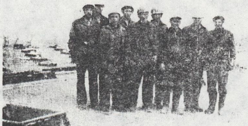
Brigada betoniarzy Leona Torchały buduje jeden z najpiękniejszych naszych obiektów — Zakład Mechaniczny „Hera” w Białymostku.
