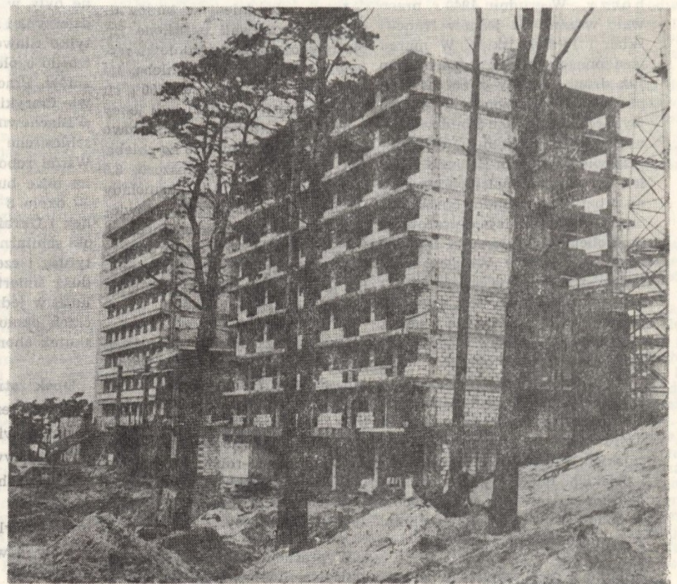
„Budowa OW „Odra” — Międzyzdroje
