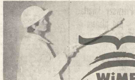
Mirosław Szczek (murarz — tynkarz) nakłada tynki na ścianę wewnątrz hali 1A.
