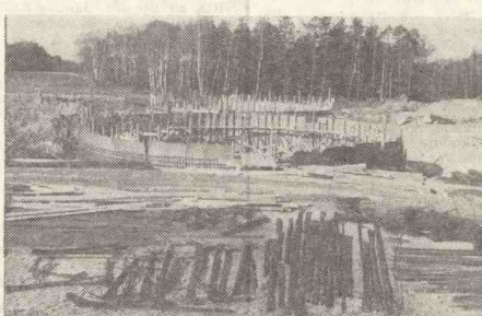
Budowa zbiorników wyrównawczych fabrycznej oczyszczalni ścieków.
