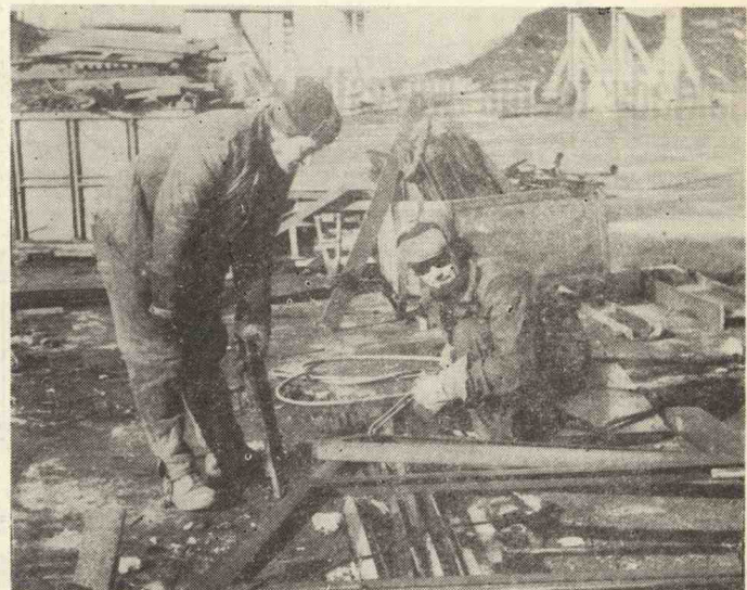
Zbudowali malarnię — oni, wspólnie z kolegami.
