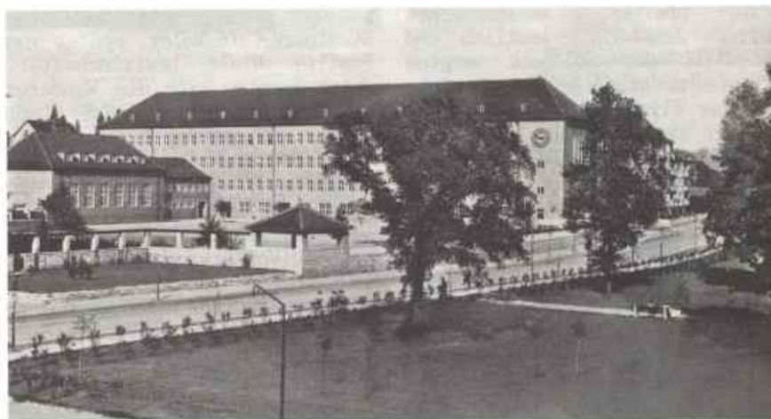
Landsberg, Blick auf die "Hermann-Göring-Schule" Foto: Archiv -eh-
