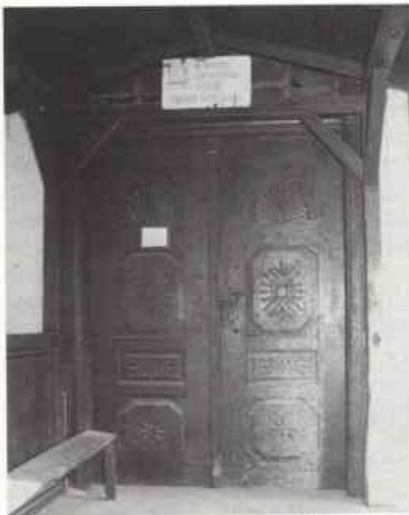
Blick auf die Eingangstür
