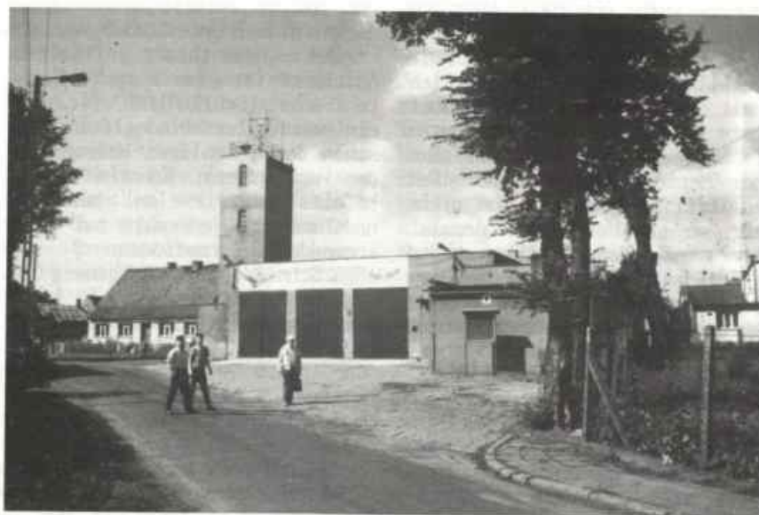
Vietz, Das neue polnische Feuerwehrgerätehaus in der Wassergasse
