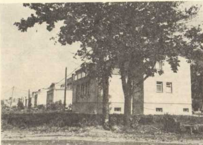
Ciąg domków WB-34-16, widok od zachodu.
