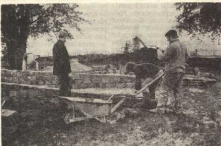
Tak powstawały zręby centralnej betoniarni
