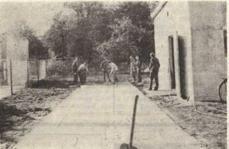
Prace końcowe przy porządkowaniu terenu.
