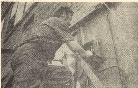
Zakładnicy elektrycy przy pracy.
