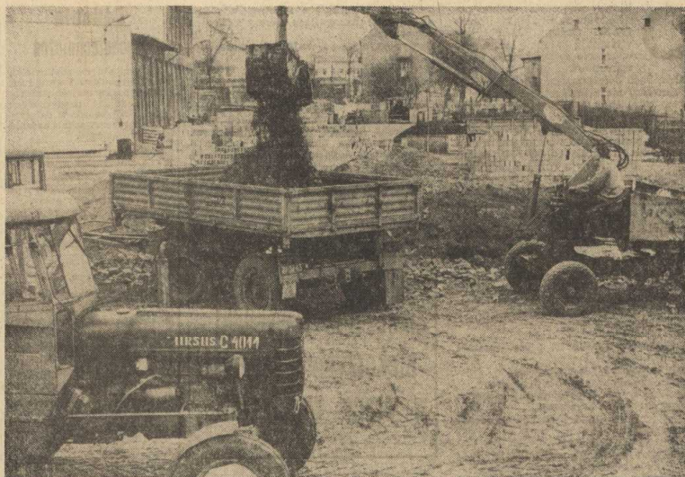
Roboty na placu pod przyszłą centralną betonarnią.
