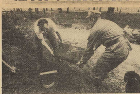
Zaloga KZP wykonuje prace ziemne pod oświetlenie parku miejskiego.
